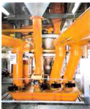
Teilansicht des Mischwerkes
